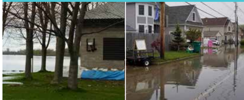
Figure 7 : Exemples d'inondation d'infrastructures municipales. À gauche - Inondation à proximité de la station de pompage d'eau, Edwardsburg-Cardinal (Ontario) (source : Edwardsburg-Cardinal). À droite - Route et égouts inondés, Greece (New York), mai 2019 (source : CMI)
